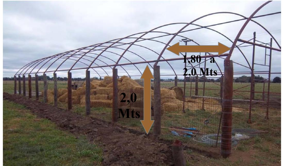
La estructura tubular, se monta sobre postes de madera dura o tratada.
