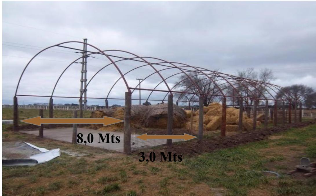
El piso es totalmente de tierra, si se puede incorporar arena y piedra para ayuda a una mejor circulación de los liquido y en el extremo norte hacer un piso de concreto de 3 m por el ancho del galpón para la ubicación de los comederos y bebedero.
