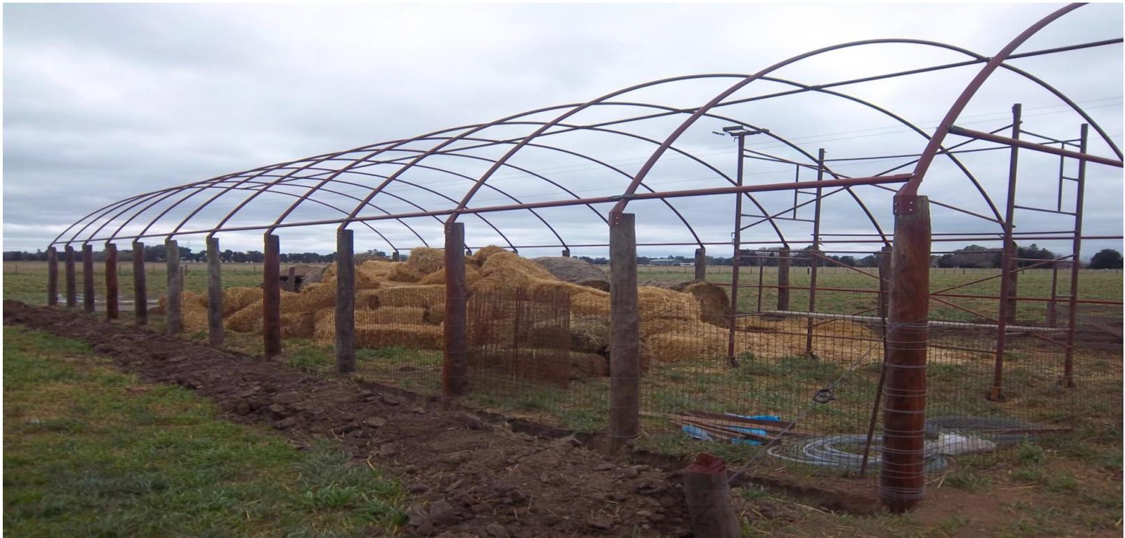
El túnel tiene un largo de 22-24 mts con un ancho de 8 mts.
