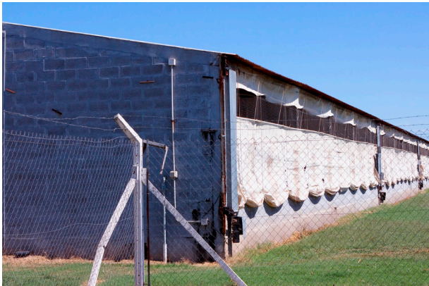
Los galpones deben estar separados del resto del establecimiento por un cerco perimetral interno.
