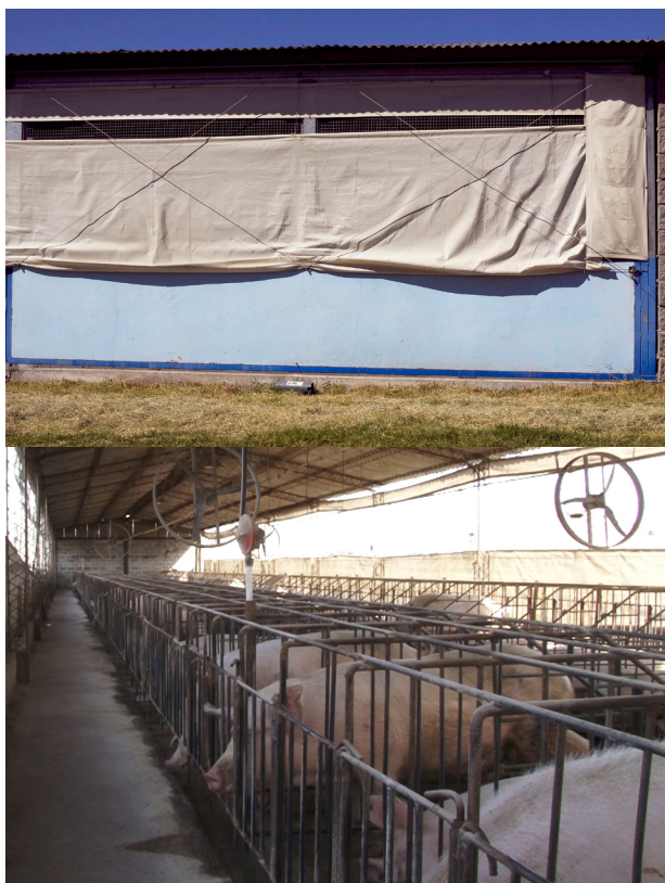
Galpones con mallas y cortinas intactas para evitar ingreso de aves y alimañas.
