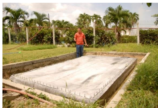
Foto 1 y 2. Biodigestor tipo túnel (Izquierda bolsa de polipropileno, derecha EPDM de fabricación nacional)
