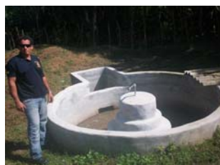
Fig.2. Biodigestor de Cúpula Fija
