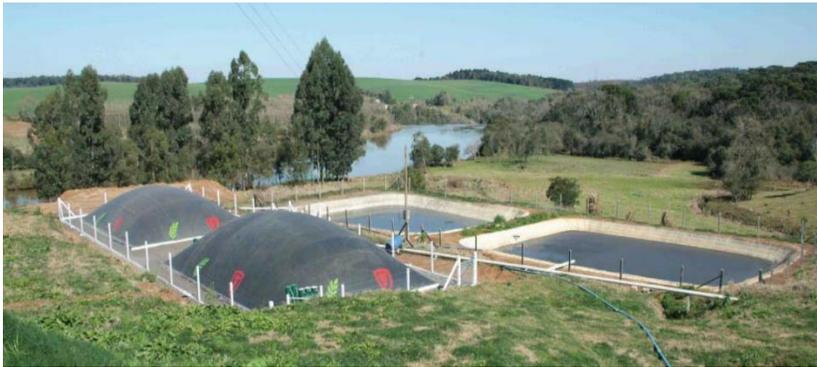
**Figura N° 12.** Biodigestor con geomembrana.
