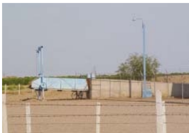
Rampa de carga
