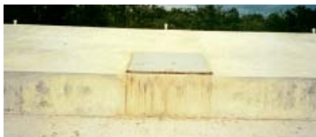
Pits de concreto
