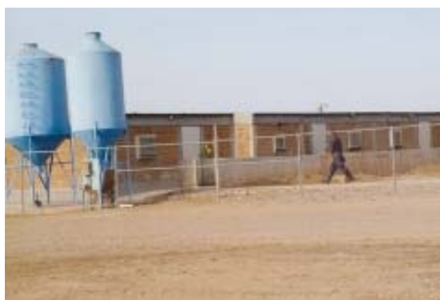
Pasillos de comunicación dentro de la granja
