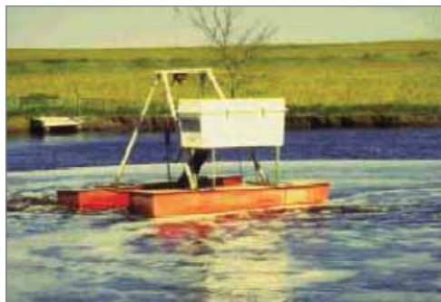
Figura 18. Laguna aireada mediante ventiladores mecánicos.
