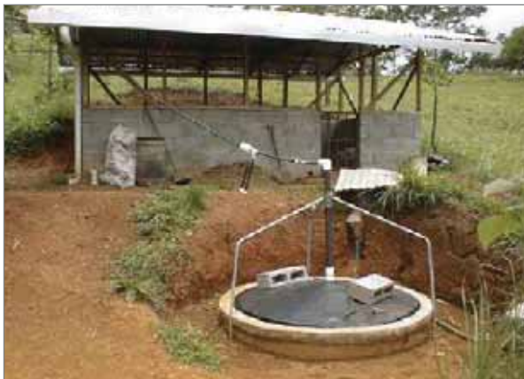
Figura 13. Fotografía de instalaciones de un tratamiento anaeróbico con biomasa suspendida a mezcla completa.
